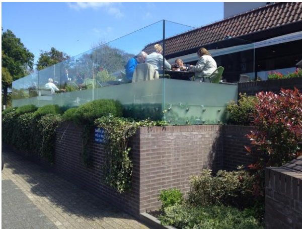
Het talud is vervangen door een keerwand met bloembak (model v.d. Valk).
